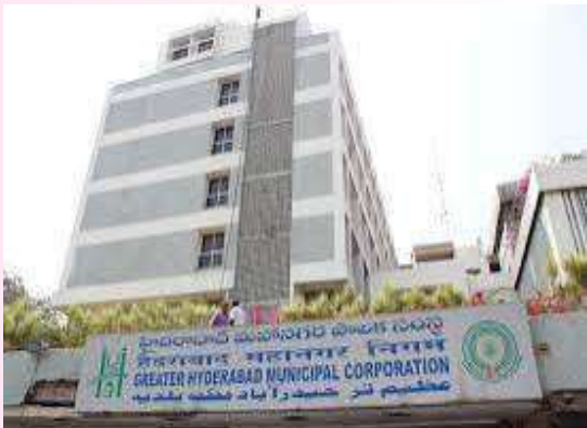
40 వేలకు చేరిన అక్రమ నిర్మాణాలు
